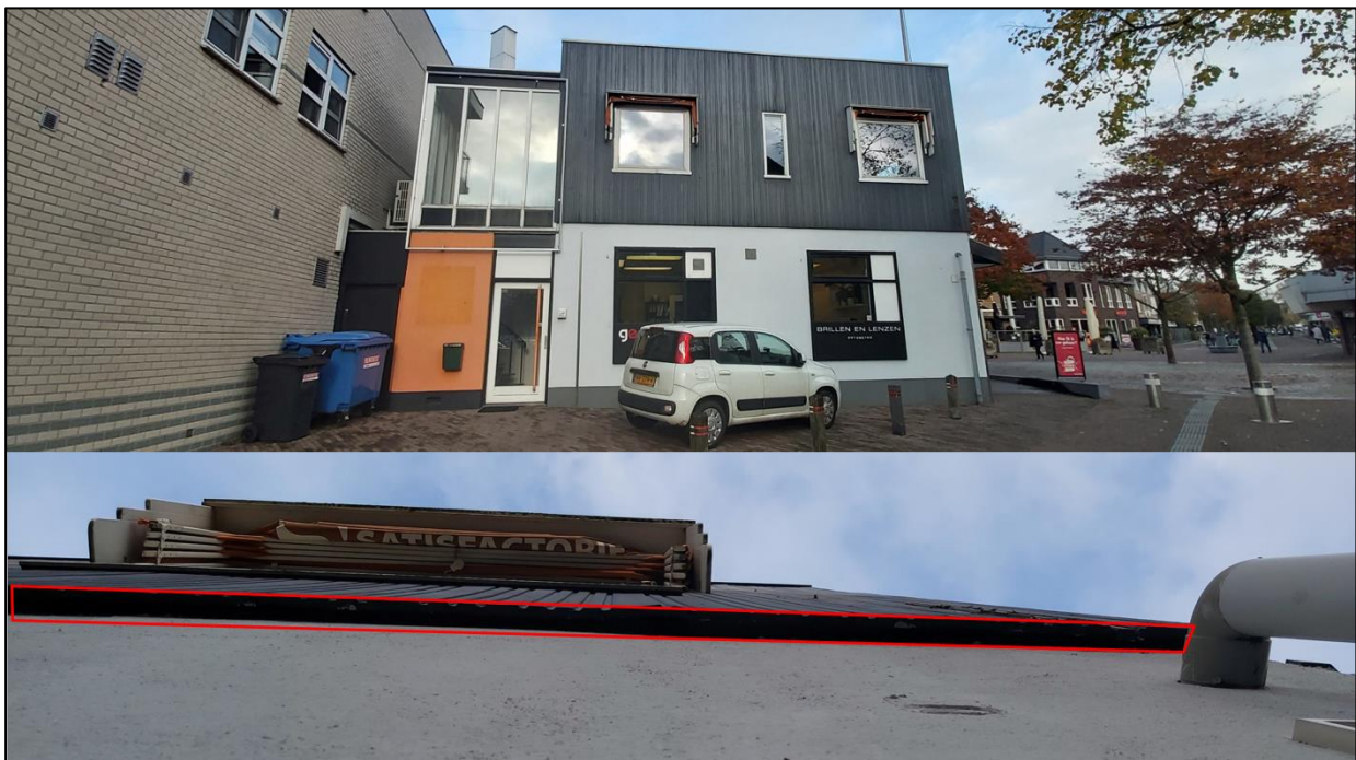
Afb. 6.4.1 Gebouw aan de Stationsstraat 95 met geschikte ruimte voor vleermuizen onder de houten beplating (rood).
