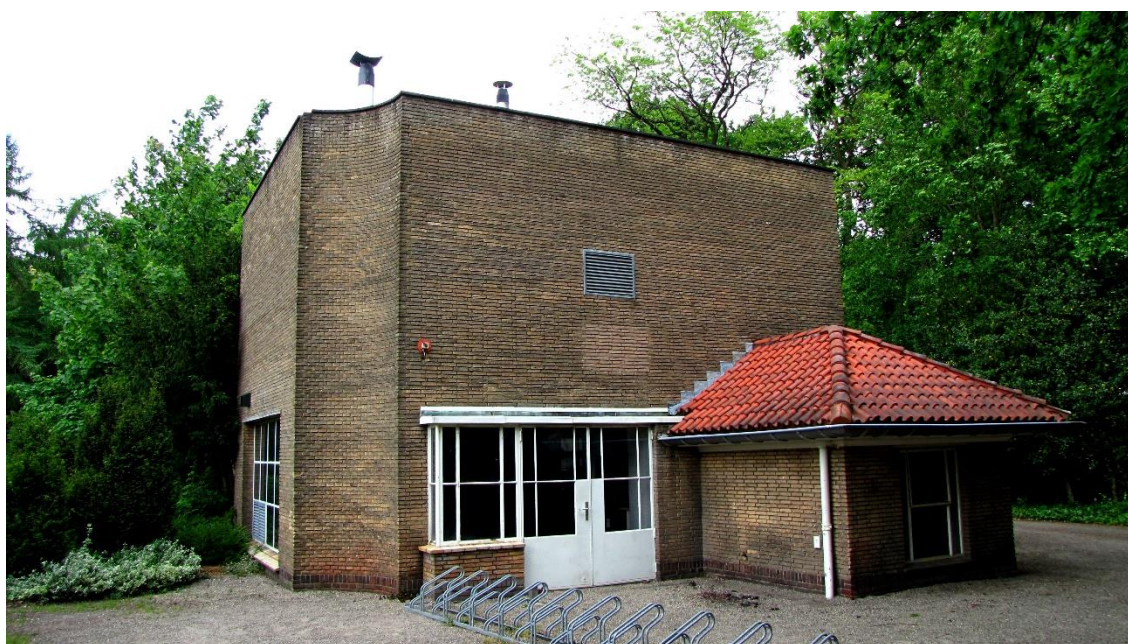
Figuur 12. Het ketelhuis achter het hoofdgebouw.
