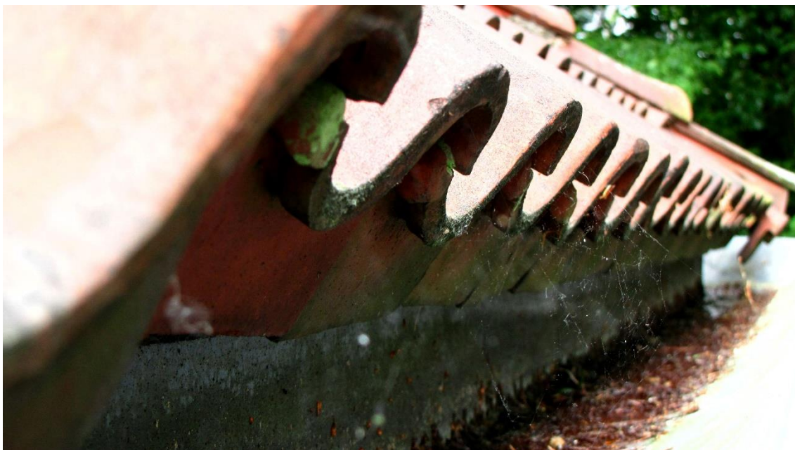
Figuur 13. De dakpannen van het hoofdgebouw en van het ketelhuis geven geen ruimte voor huismussen om onder het pannendak te komen.
