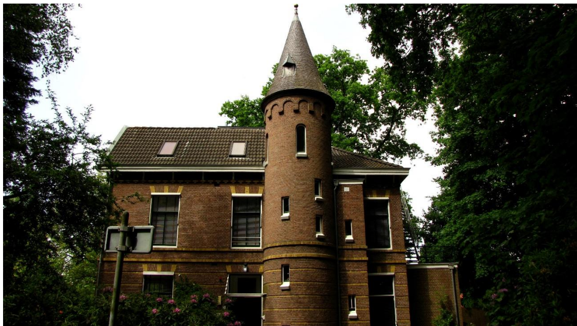
Figuur 7. Het kantoorgebouw met dakpannen en leistenen daken. De houten gevelbekleding kiert her en der. Voor vleermuizen biedt dit pand mogelijkheden voor vaste rust- en/ of verblijfplaatsen.
