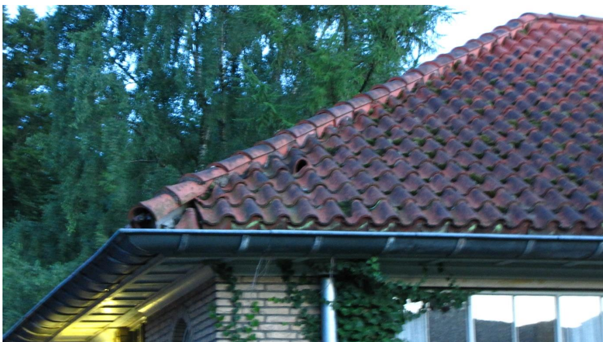
Figuur 4. Verspreid over het dak van het hoofdgebouw zijn zwaluwpannen te vinden. Vijf daarvan werden daadwerkelijk gebruikt door gierzwaluwen.
