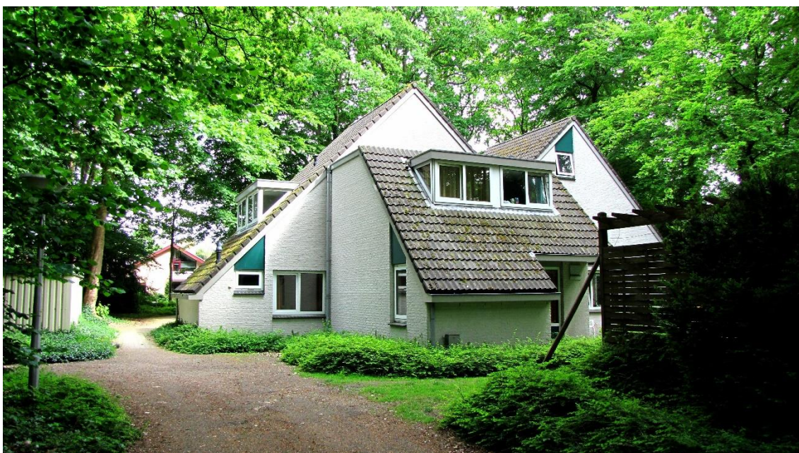
Figuur 14. De woonhuizen in het oosten van het plangebied. Deze panden beschikken over soortgelijke pannen als het hoofdgebouw en het ketelhuis.
