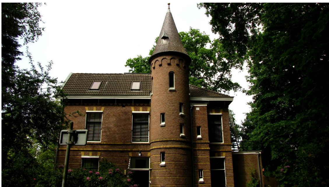
Figuur 7. Het kantoorgebouw met dakpannen en leistenen daken. De houten gevelbekleding kiert her en der. Voor vleermuizen biedt dit pand mogelijkheden voor vaste rust- en/ of verblijfplaatsen.
