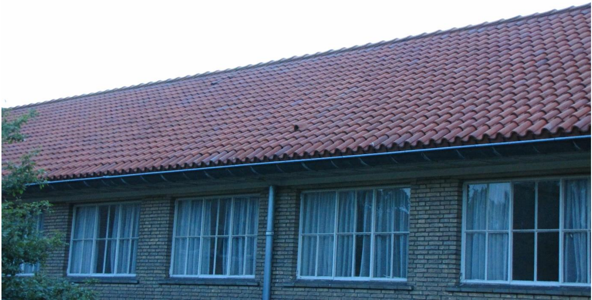
Figuur 19. De zwaluwpan wordt gebruikt als invliegopening naar de nestlocatie van een gierzwaluw.
