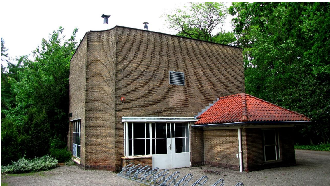
Figuur 12. Het ketelhuis achter het hoofdgebouw.
