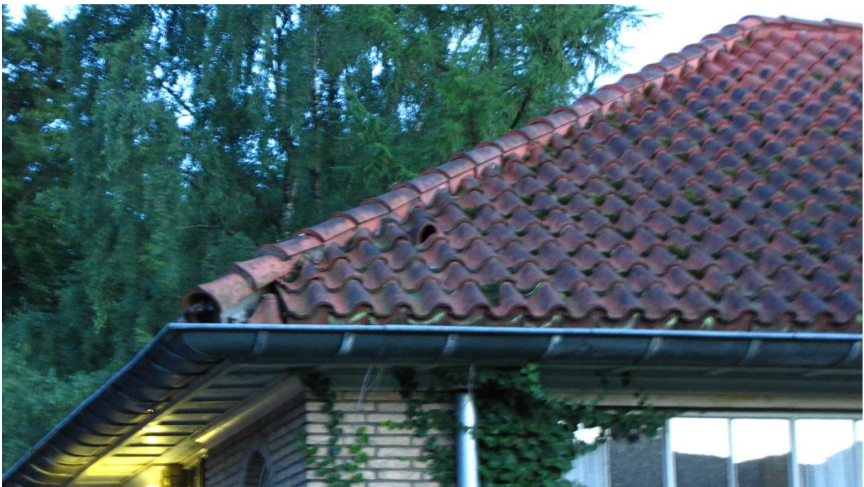
Figuur 20. Verspreid over het dak van het hoofdgebouw zijn zwaluwpannen te vinden. Vijf daarvan werden daadwerkelijk gebruikt door gierzwaluwen.
