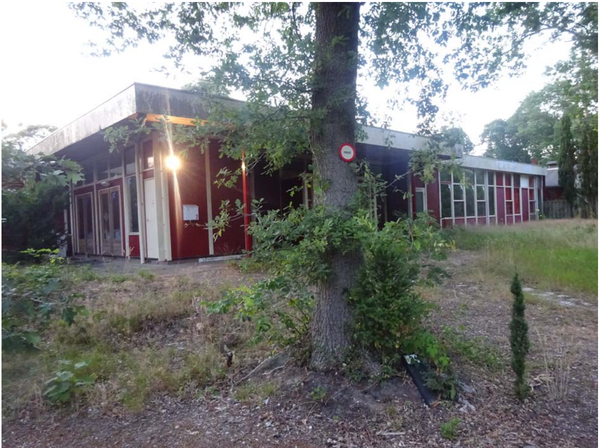
Foto 1: Impressie van het gebouw aan de Heemhoeveweg
