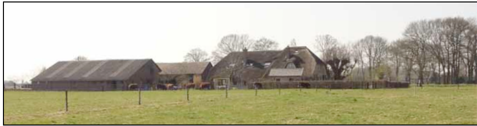
figuur 4 de boerderij gezien vanuit het noordoosten van het plangebied
