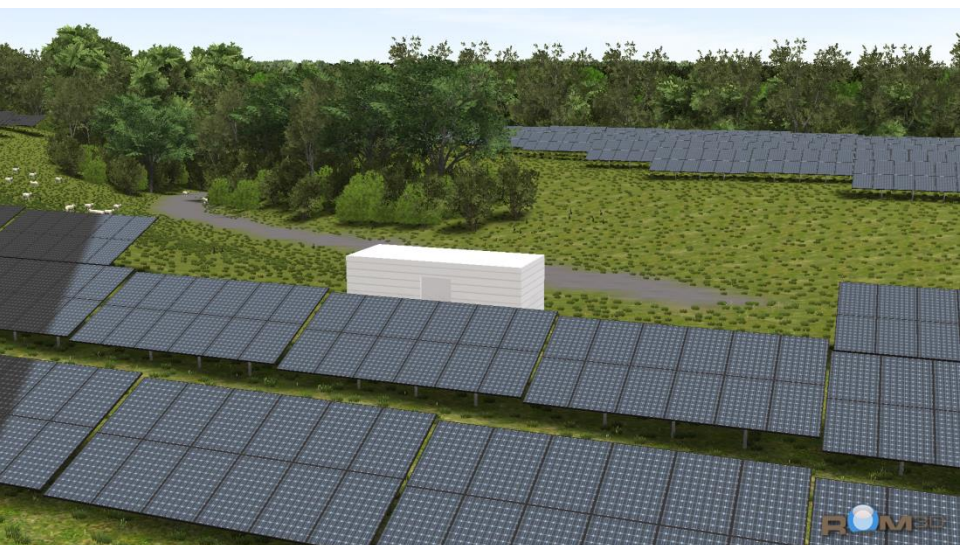
Zicht op trafo
