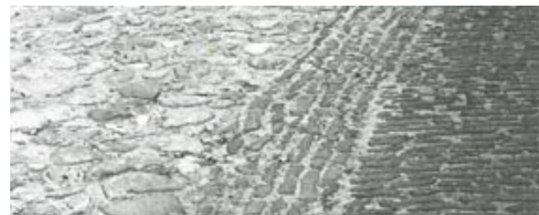
Historisch wegprofiel van keien en klinkers.
