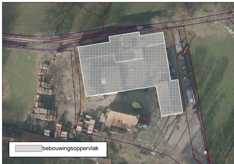
Luchtfoto bedrijfsgebouw chemische wasserij (gebouw A)
