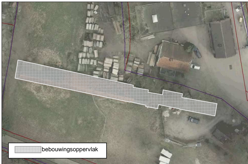
Luchtfoto agrarische bijgebouwen (gebouw C) bij Heerderweg 59
