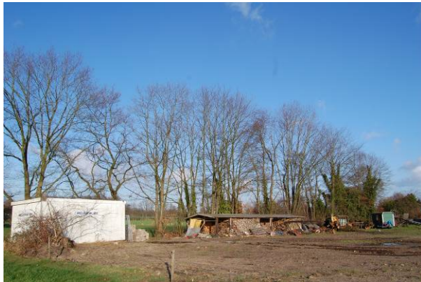
Opslagplaats bouwmaterialen en machines
