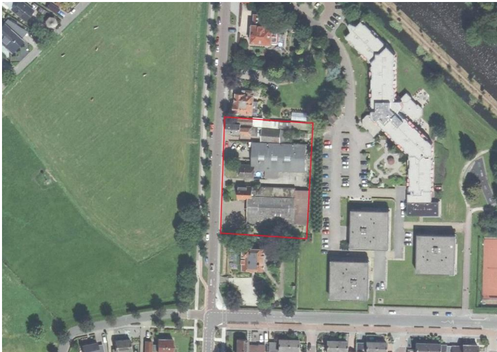
Figuur 1.1 Ligging van het plangebied (binnen rode omlijning). Bron luchtfoto: Google Earth.
