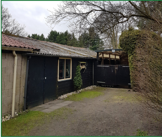
Afb. 2.6: Opgang tussen de te slopen schuur met daartegenaan een overkapping.
