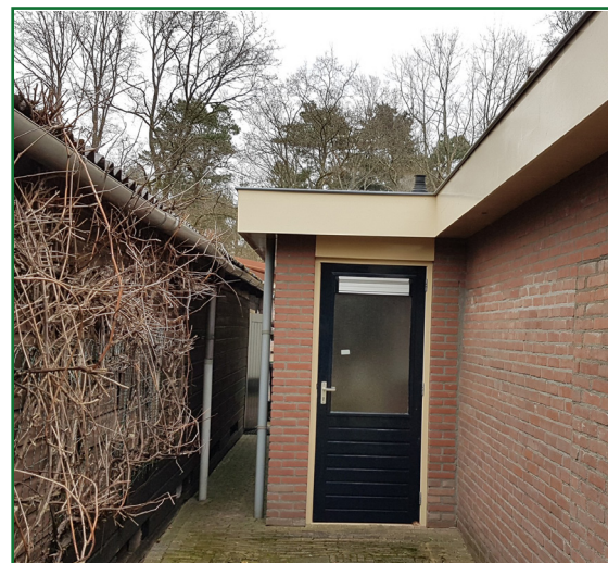
Afb. 2.5: Gangetje tussen het te slopen bijgebouw en de te slopen schuur.
