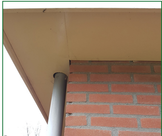
Afb. 2.9: De overstek van het bijgebouw sluit goed aan en is daarom ongeschikt voor vleermuizen.
