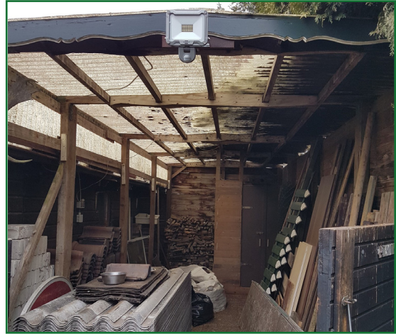
Afb. 2.7: De te slopen overkapping aan de zuidzijde van de te slopen schuur.
