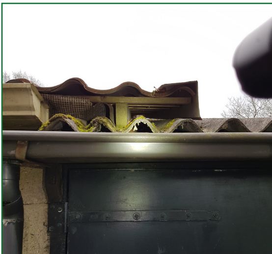
Afb. 2.10: Geschikte tussenruimte voor de huismus tussen golfplaten dak en dakbeschoot van de te slopen schuur.
