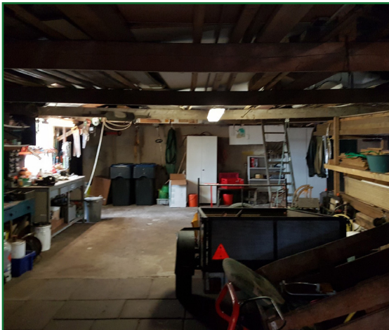
Afb. 2.8: Binnenzijde van de te slopen schuur.
