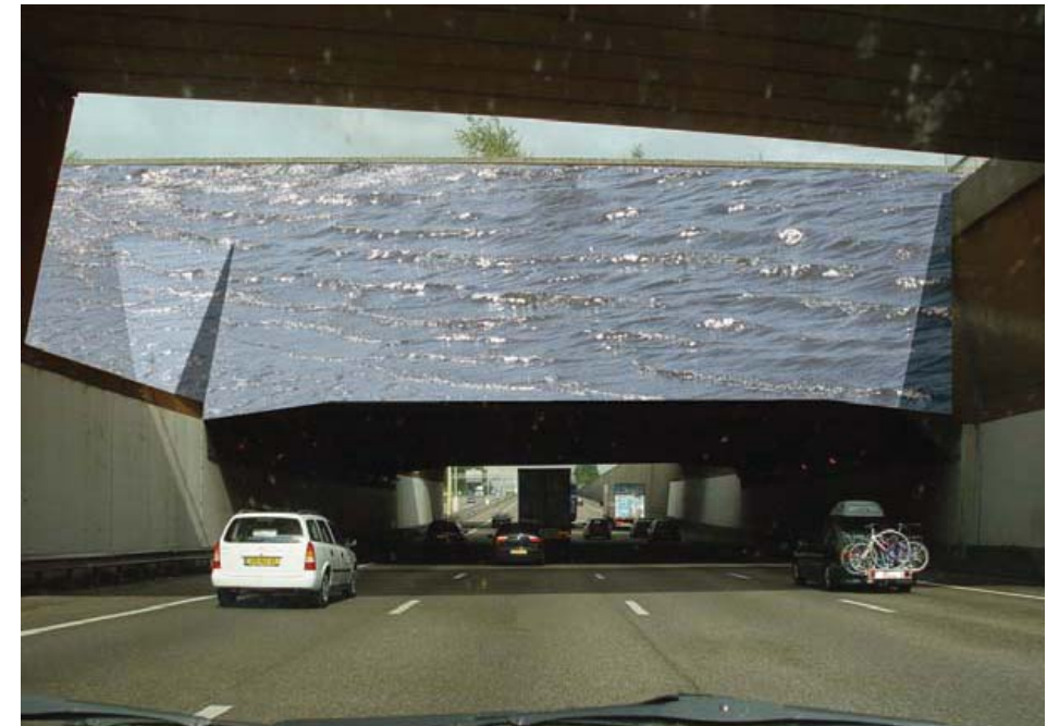
Opvallende detaillering om identiteit te versterken. Voorbeeld: Gouwe Aquaduct
