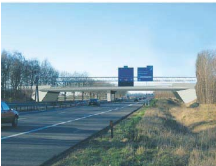
Viaduct Stad (convergerend)
