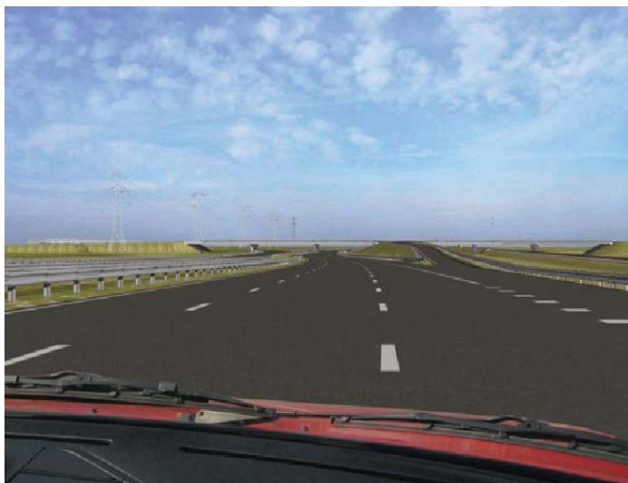
Viaduct Weide (divergerend)
