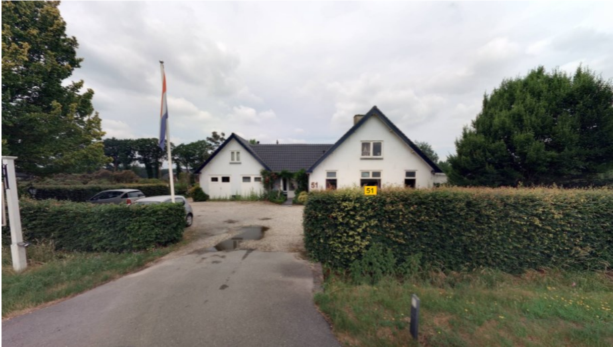
Afbeelding 2.1: Vooraanzicht bedrijfswoning met aangebouwde garage (links)
