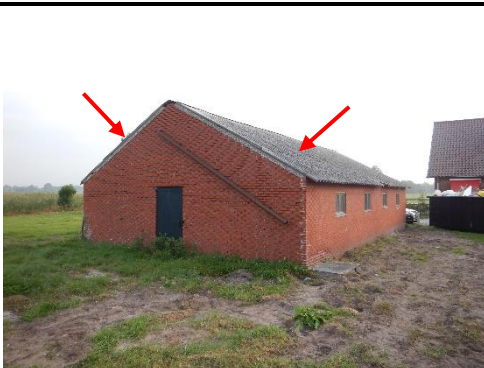
Foto 11 | Foto voor bron Golfplaten Schoor 7
