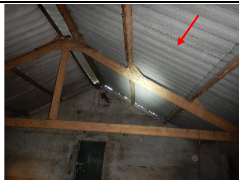
Foto 12 | Foto voor bron Golfplaten Schoor 7
