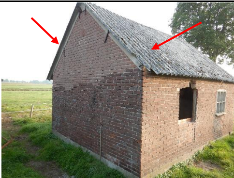
Foto 7 | Foto voor bron Golfplaten Schoor 5
