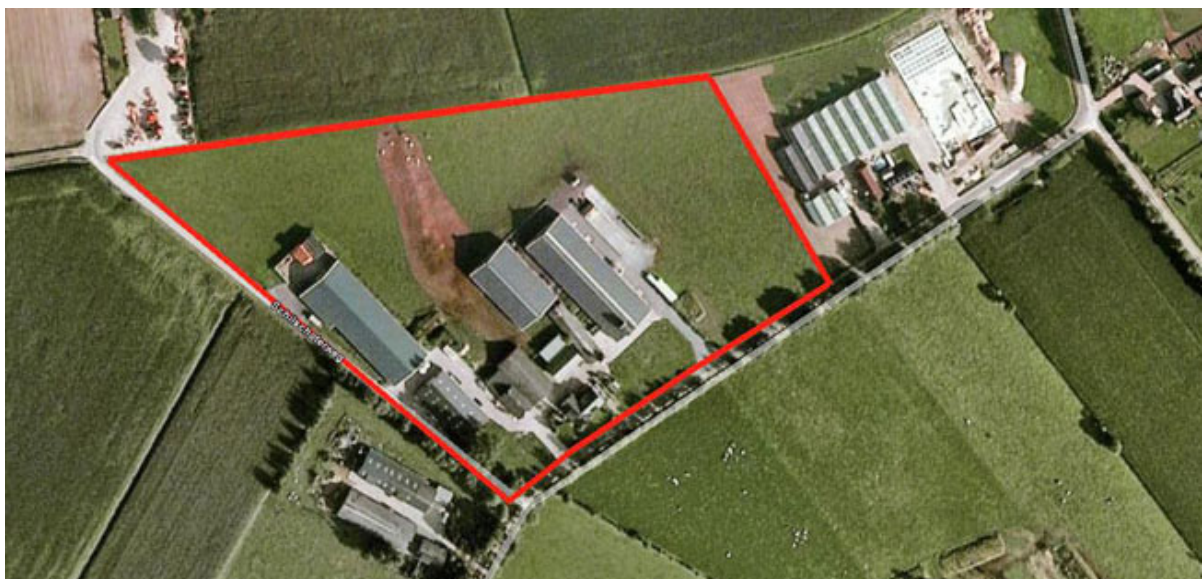
Situatie perceel (bron: Google)
