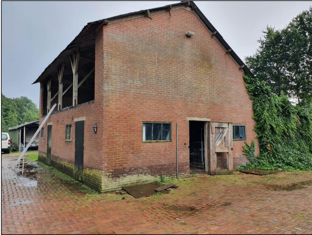
Figuur 3 Gebouw D van de planlocatie bestaat uit een kapschuur.
