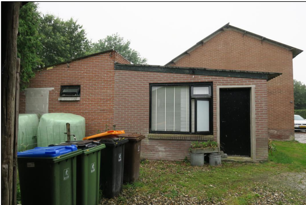
Figuur 2 Gebouw C van de planlocatie bestaat uit gemetselde muren en een golfplaten dak.
