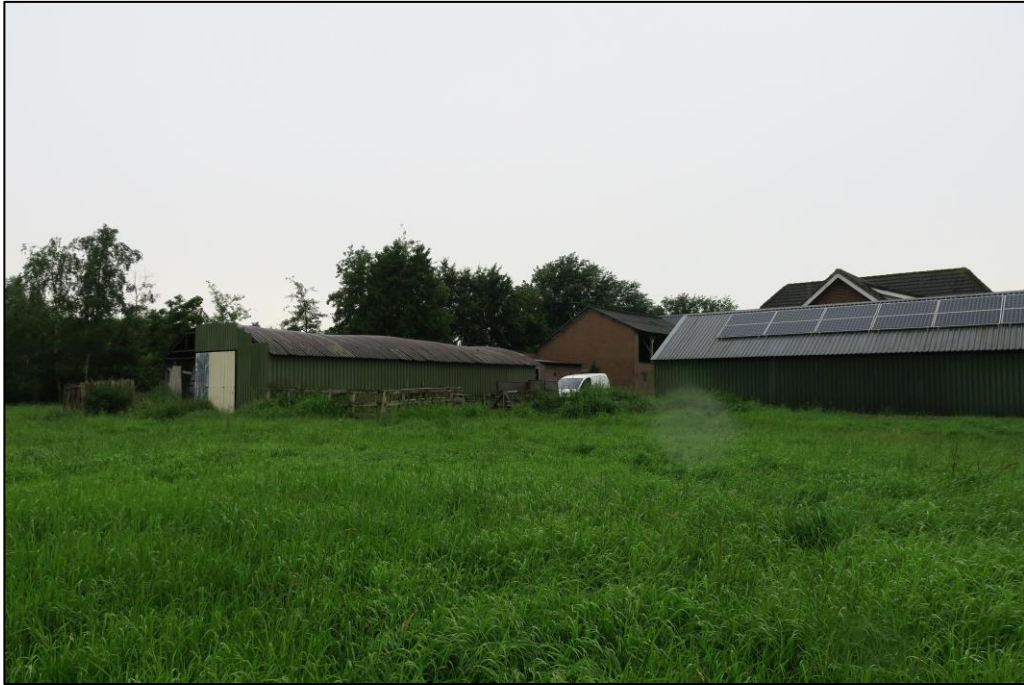
Figuur 1 De planlocatie is gelegen is aan de Veldhoek 8 te Lunteren, waar 4 schuren gesaneerd zullen worden. Gebouw A van de planlocatie (rechts) bestaat uit metalen platen, er liggen zonnepanelen op het dak. Gebouw B van de planlocatie bestaat uit metalen damwand platen met een golfplaten dak (links).
