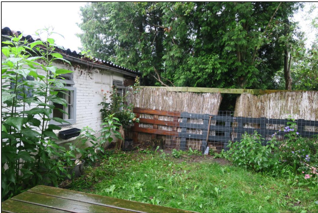
Figuur 4 Gebouw E van de planlocatie bestaat uit gemetselde muren en een golfplaten dak. Dit gebouw blijft behouden.
