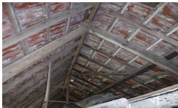
Dak met dakpannen
