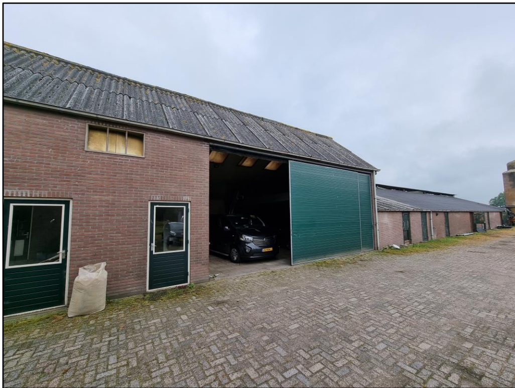
Figuur 2 De te saneren opslagschuur en voormalige varkensstal. Beide panden zijn opgetrokken uit gemetselde muren met een golfplaten zadeldak.
