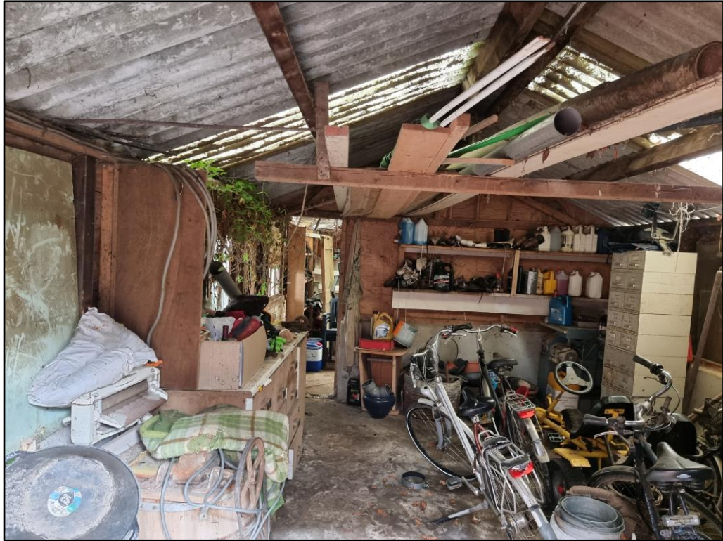
Figuur 3 Het ter saneren tuinhuis is opgetrokken uit houten wanden met een golfplaten dak zonder dak- of spouwruimte.
