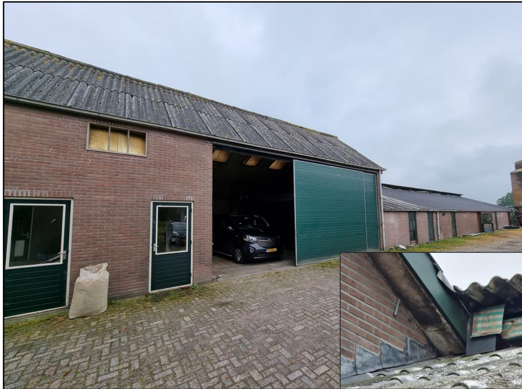
Figuur 4 De gevels van de te saneren bebouwing bevatten geen open stootvoegen, de gevels en golfplaten sluiten nauw aan op de dakrand (de overstekende golfplaten rechtsonderin zijn voor ontluchting van de voormalig varkensschuur).
