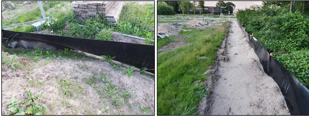
Figuur 3 Een incorrect geplaatst amfibiescherm (links). Een correct geplaatst amfibiescherm (rechts). Deze dienen minimaal 10 cm ingegraven te zijn.
