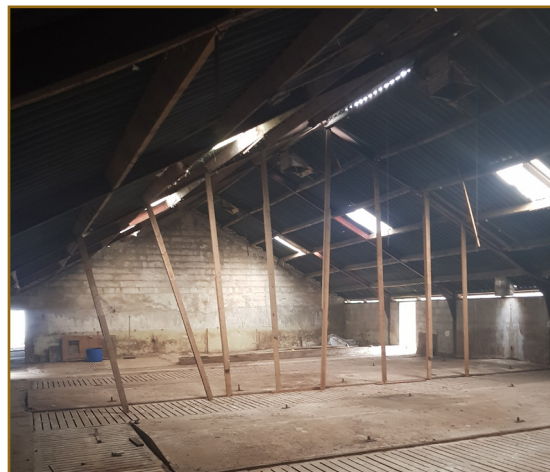
Afb. 2.8: De grote ruimte aan de binnenkant van de westelijke varkensstal. Er werden geen nesten of (potentiële) vleermuisverblijfplaatsen aangetroffen.
