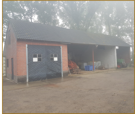
Afb. 2.2: Overzichtsfoto van de kapschuur.
