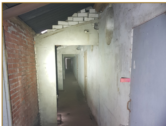
Afb. 2.5: Zigang van de oostelijke varkensstal. Er werden geen nesten of (potentiële) vleermuisverblijfplaatsen aangetroffen.
