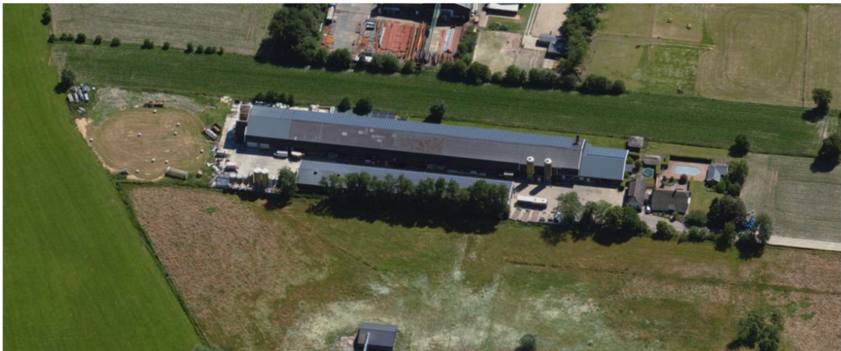
Afbeelding, bouwlocatie Meikade 38 (Bron: Street Smart, 22 juni 2022)
