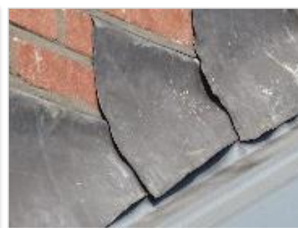
Foto 9: Lood bedekking dak.
