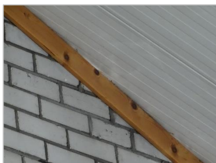
Foto 17: Afdichting met een lat.
