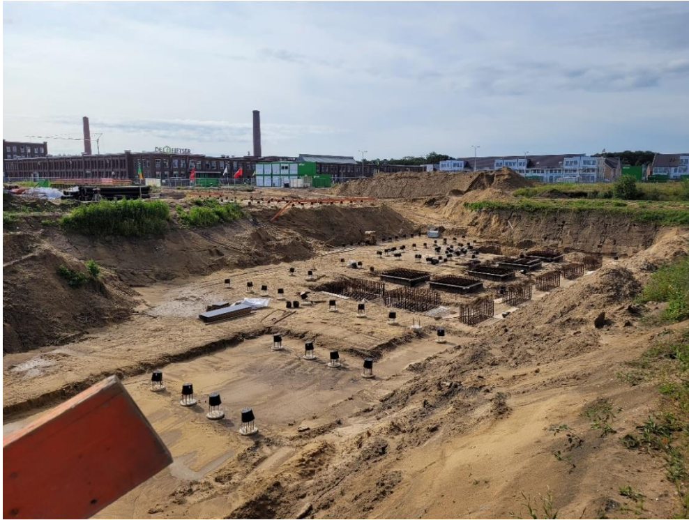
Figuur 2.7 Ten noorden van het plangebied ligt een bouwlocatie waar gewerkt wordt aan de fundering
