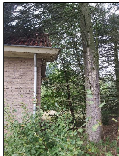
Figuur 3 Boom op zeer kleine afstand van de bebouwing
