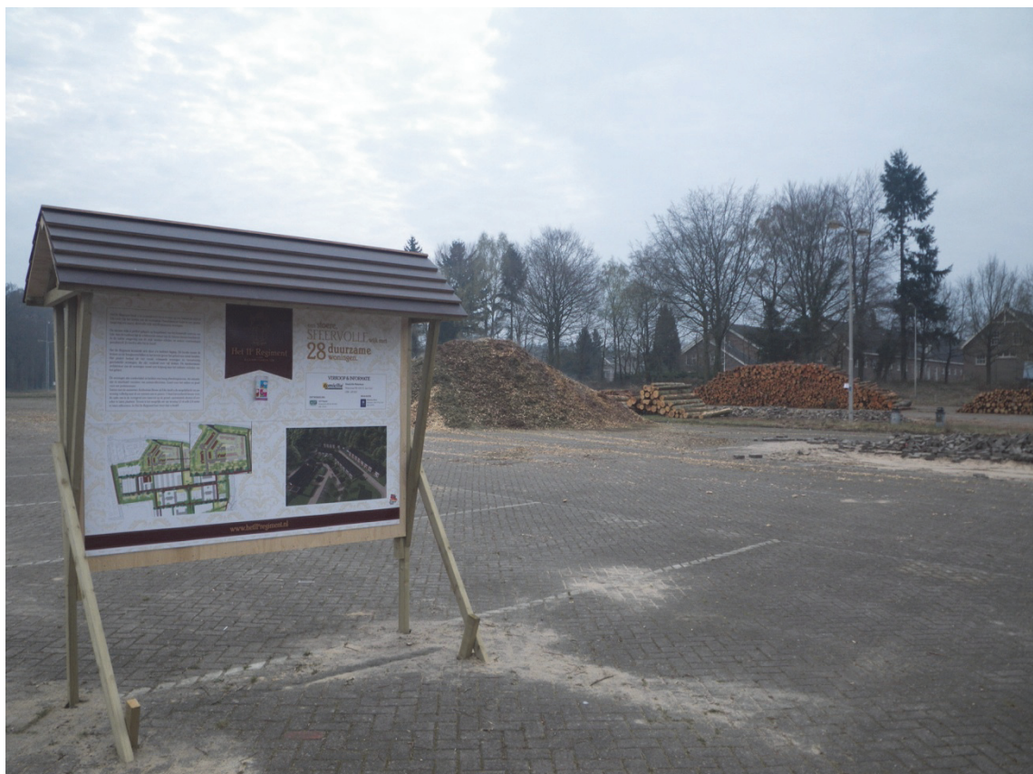
Fig. 1.2: Sfeeropname locatie 4A voor aanvang van de werkzaamheden.
