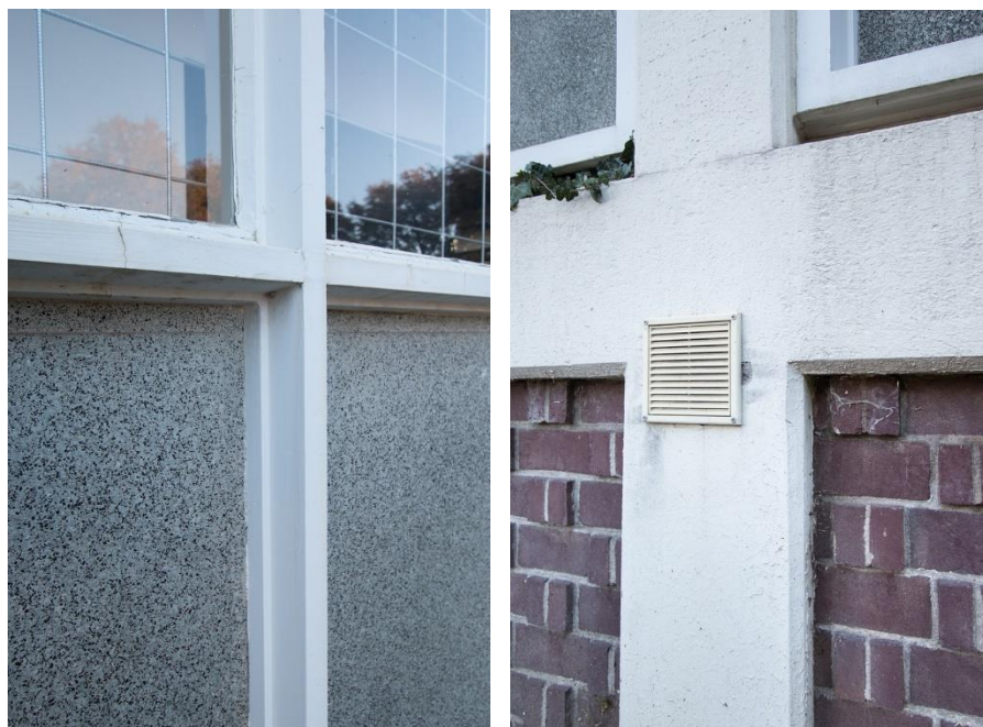
Borstwering met steenslagpanelen in de gewapend betonnen kozijnen en rechts met siermetselwerk ter opvulling van het betonskelet.
