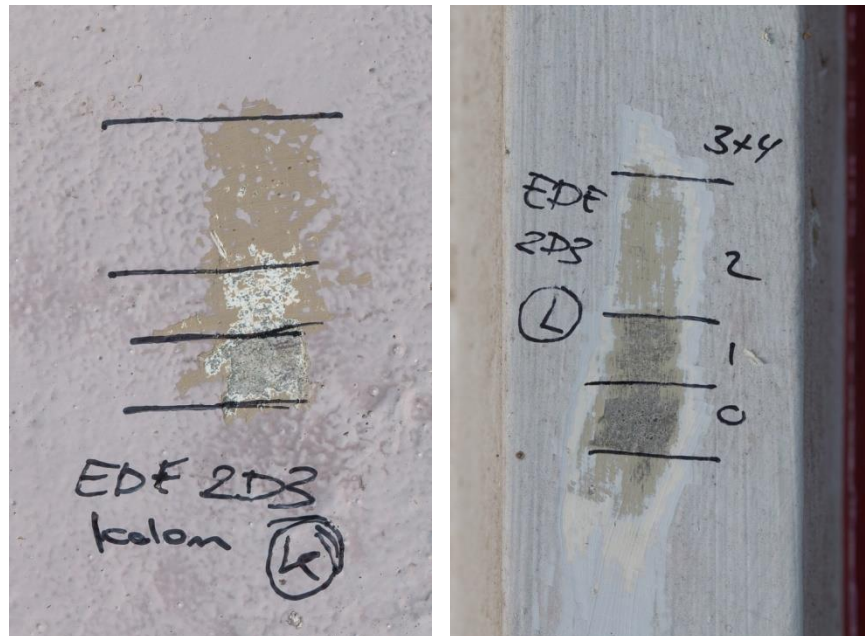
Kleurentrap K, kolom onder trapbordes noordgevel. Rechts kleurentrapje L op de betonomlijsting van een venster in de westgevel (onder het trapbordes).
