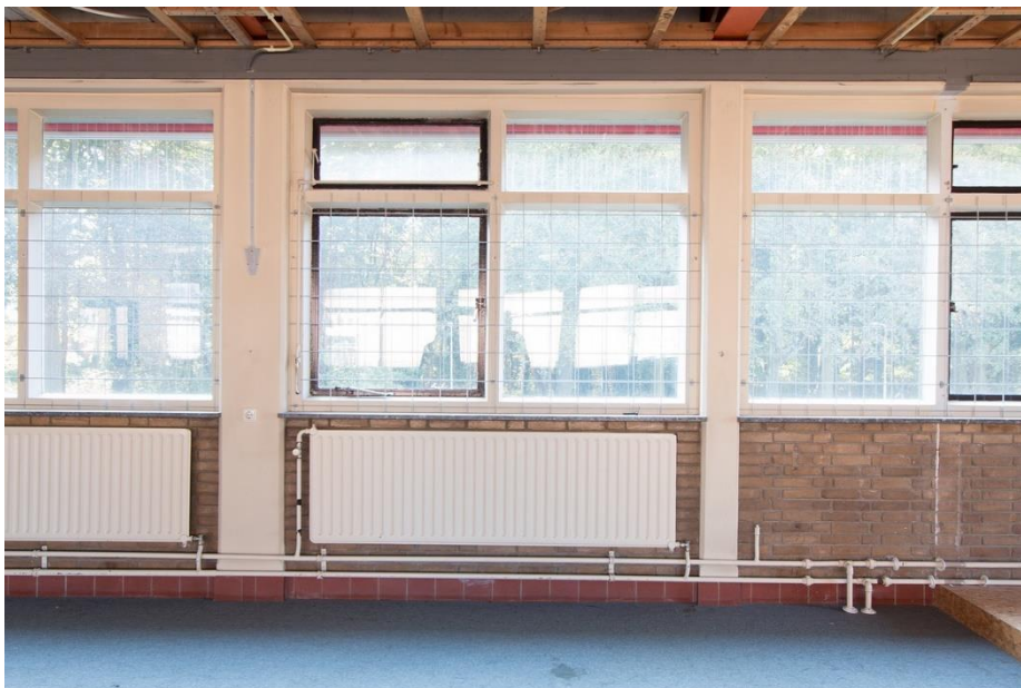
In de voormalige korporaalseetzaal is de stahoogte minder groot. In de gevel zien we de gewapend betonnen kolommen en nog net de einden van de stalen balken die er zijn opgelegd.
