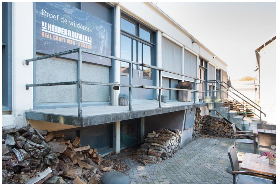
Laadperron met vermoedelijk toegevoegde trap en hekwerk. Ter plaatse van de trap de secundaire toegangsdeur en kort daarvoor een laadluik waarachter oorspronkelijk een transportband stond opgesteld.
