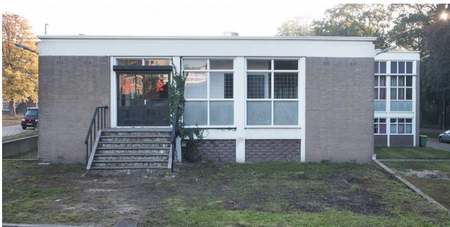
De in het landschap verzonken westgevel is ondergeschikt aan de overige gevels. De entreepartij bood aanvankelijk toegang tot de korporealsmess. De beplanking van de trap dateert niet uit de bouwtijd.
