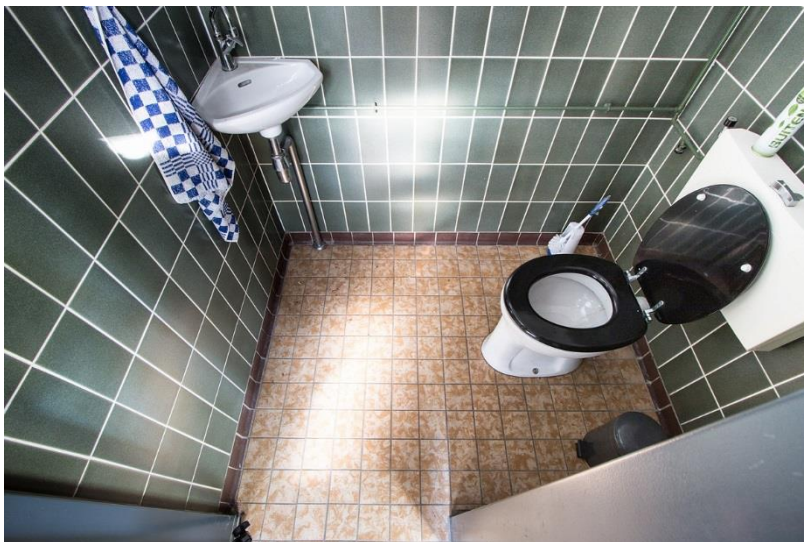
Niet oorspronkelijk toilet in het westelijke bouwdeel.
