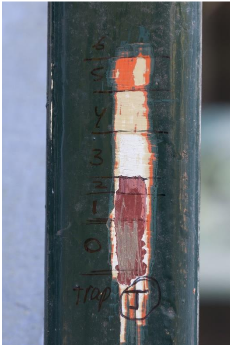
Kleurentrap J op één van de spijlen van de brandtrap tegen de zuidgevel.
