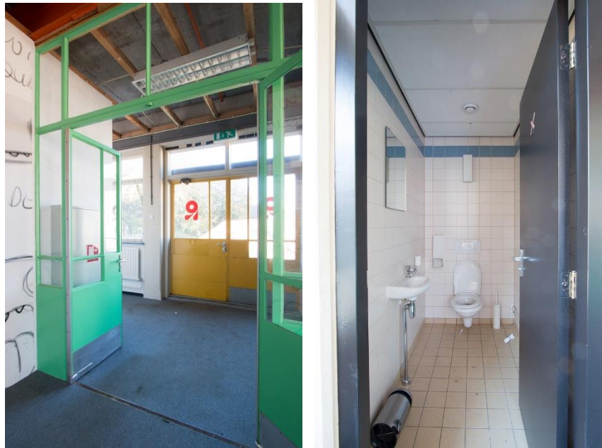
De voormalige entree en garderobe vanuit de zaal gezien. Rechts de gemoderniseerde toiletgroep.
