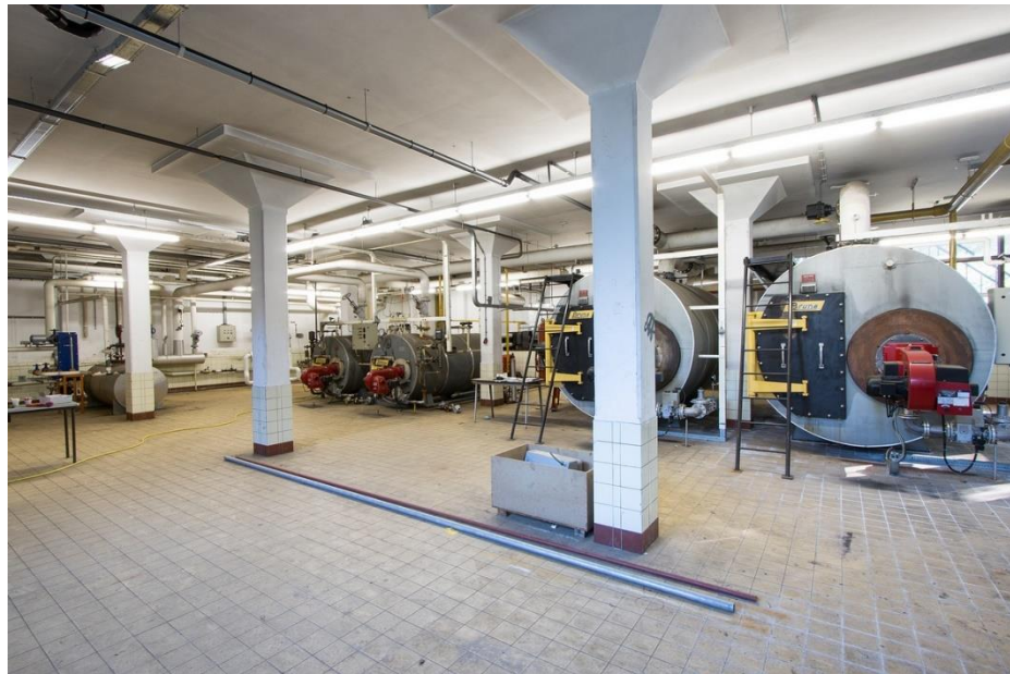
Het ketelhuis met kolommen voorzien van paddenstoelkoppen onder de vloer van de eetzaal.
