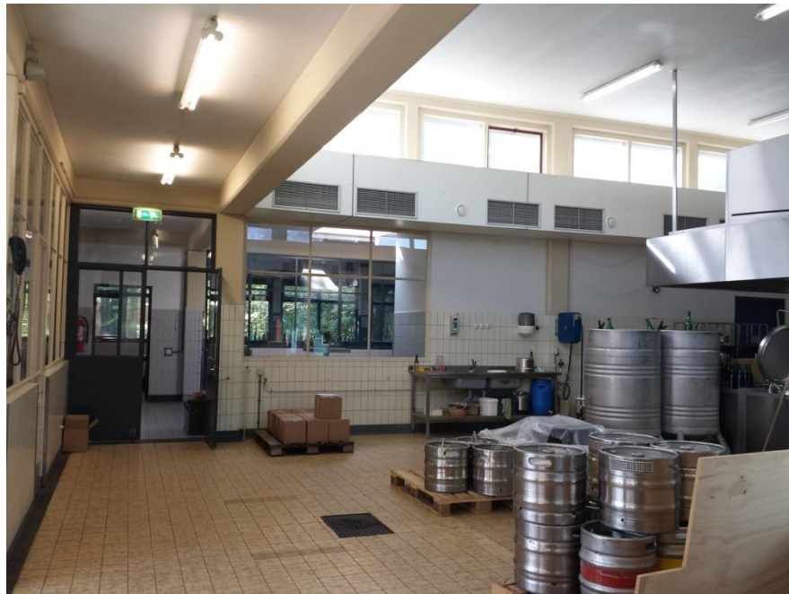
Centrale keuken van het gebouw. Om deze ruimte zijn alle andere vertrekken gegroepeerd. Let ook op de bovenramen en de plaatselijke verhoging van het platte dak.
