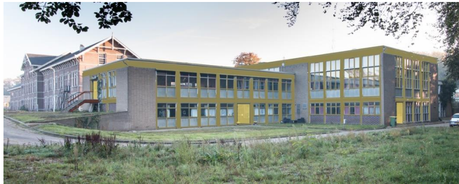
Globale indruk van de oudst aanwezige kleurstelling van het pand. Groen in plaats van wit, stalen deuren in geel en stalen trappen in rood. De tinten rood en geel komen in het metselwerk ook voor. In combinatie met de grijzige kleur van de steenslagpanelen is het kleurenpalet daarmee compleet.
