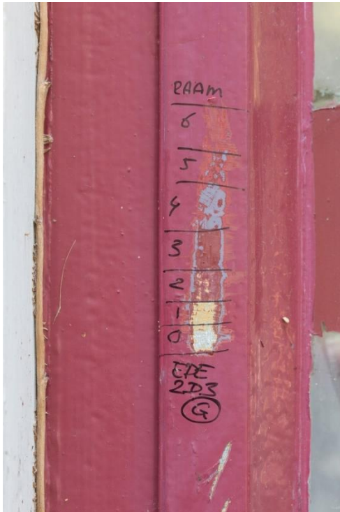
Stalen raam in de zuidgevel van het gebouw met kleurentrapje G.
