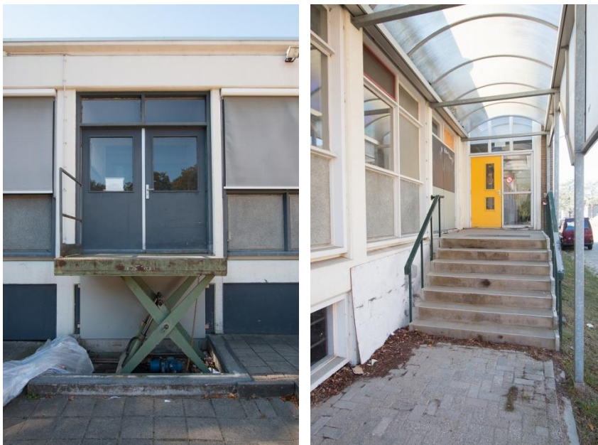
Oostgevel, secundaire goederenlift aansluitend op een deurenkozijn dat in hout is uitgevoerd en dus van latere datum is. Rechts de secundaire luifel in aluminium tegen de noordgevel. Entreepartij vernieuwd met houten kozijn en houten deur.
