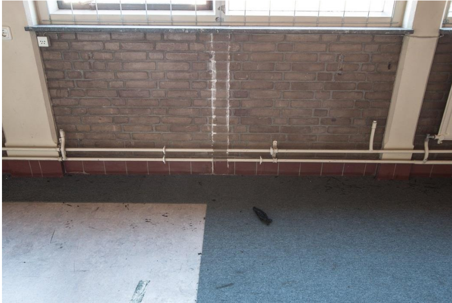
Vloerafwerkingen en tegelplint die wijzen op een nog verborgen tegelvloer.
