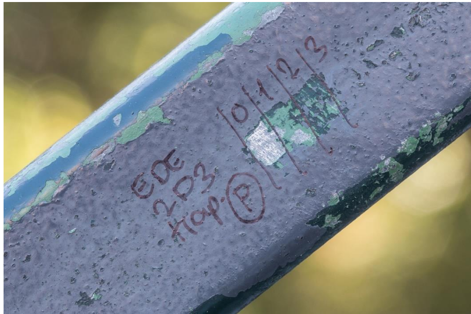
Kleurentrapje P op de handlijst van een trap aan de oostzijde van het gebouw.
