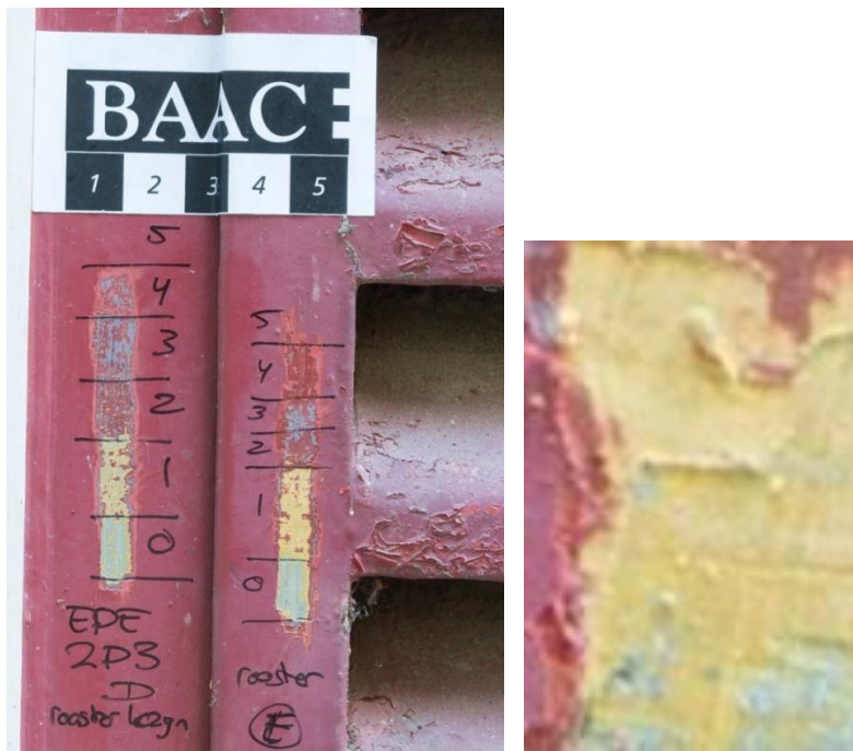
Twee kleurentrapjes (D en E) op het stalen rooster in de zuidgevel en het kozijn waarin het is aangebracht. Rechts een uitsnede met de twee tinten geel.
