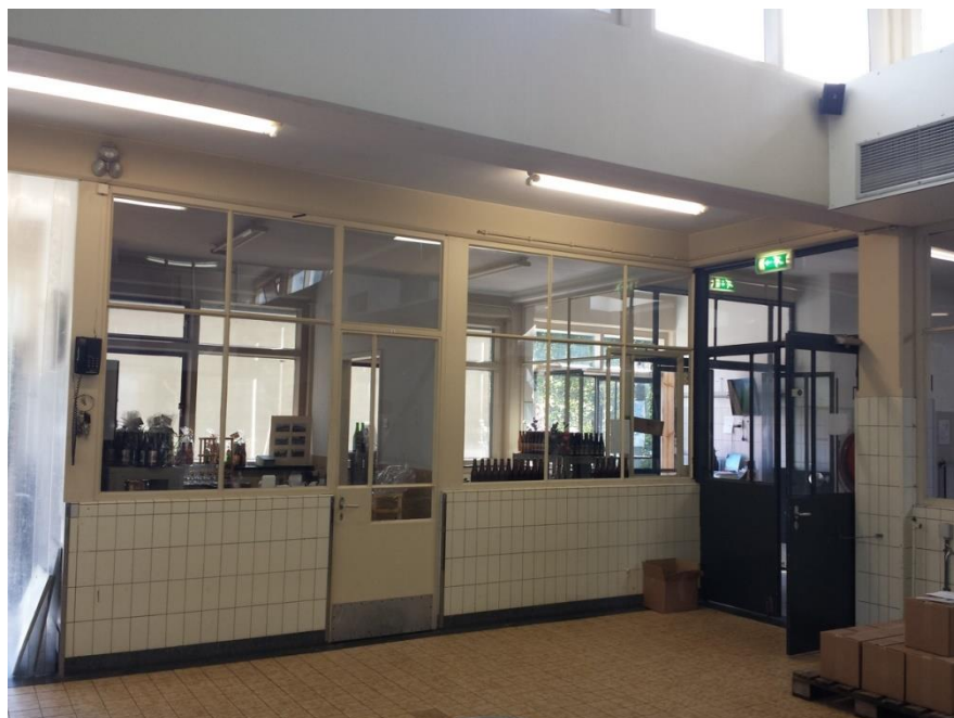
Op basis van de opnamen is niet met zekerheid te stellen of vloer- en wandbetegeling uit de bouwtijd dateren. Opname 2014.
