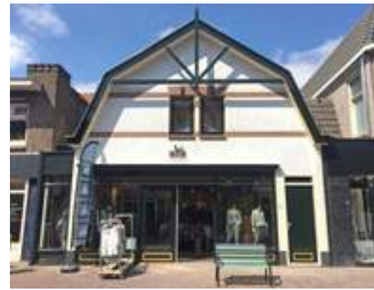
Na gevelverbetering (Maandereind 36)
