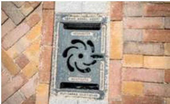
Kolk en gootlijn precies passend, Nering bogel met waaierdeksel voor hemelwaterkolken
