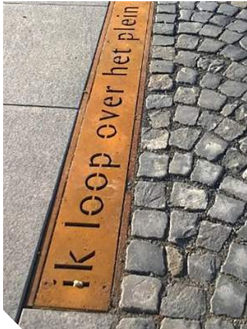
Kolk en gootlijn precies passend, Nering bogel met waaierdeksel voor hemelwaterkolken
