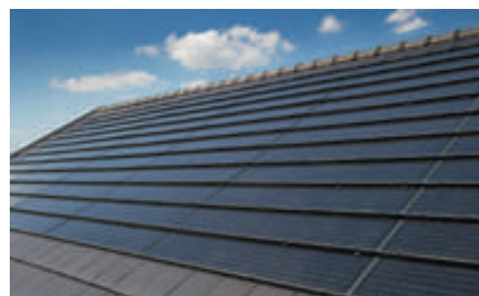
Fraai geïntegreerde zonnepanelen
