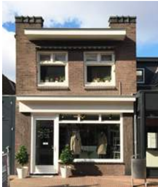
Na gevelverbetering (Maandereind 38)
