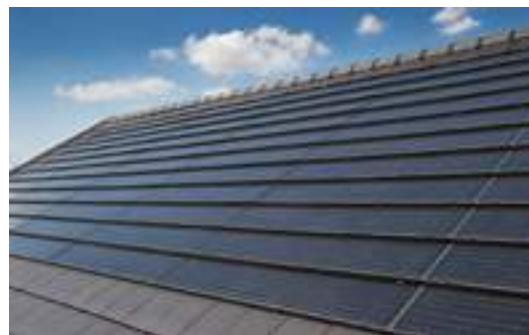
Fraai geïntegreerde zonnepanelen
