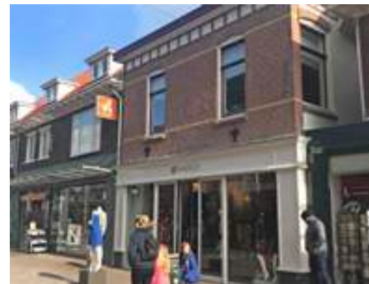
Na gevelverbetering (Grotestraat 12)
