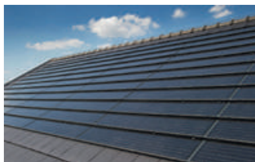
Fraai geïntegreerde zonnepanelen
