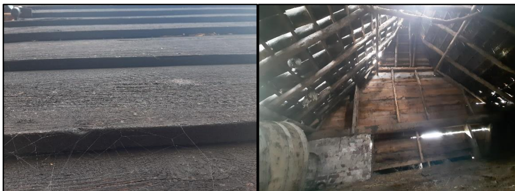
Figuur 4 De potdeksels op gebouw C sluiten nauw aan (links) en hebben geen bedekking aan de binnenzijde (rechts), waardoor er geen sprake is van potentiële verblijfplaatsen voor vleermuizen.
