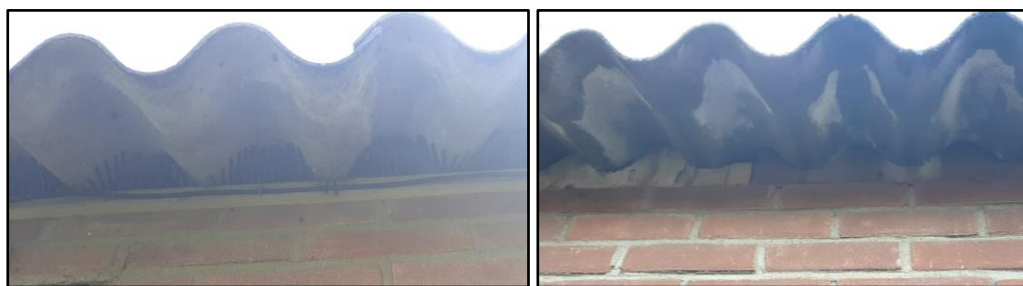
Figuur 5 De daken van gebouw B en E zijn niet toegankelijk voor huismussen door de aanwezigheid van houten panelen (gebouw B, links) en vogelschroot (gebouw E, rechts).
