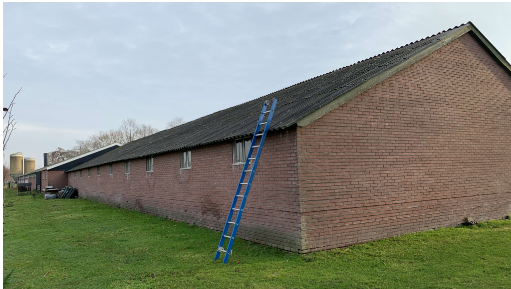
Figuur 2 De dakrand van de schuur 1 (figuur 1) biedt potentiële verblijfplaatsen voor huismus
