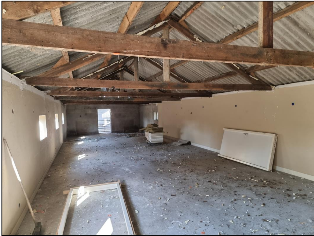
Figuur 3 De schuren en voormalige stallen op de planlocatie zijn reeds ontdaan van dakbeschot.
