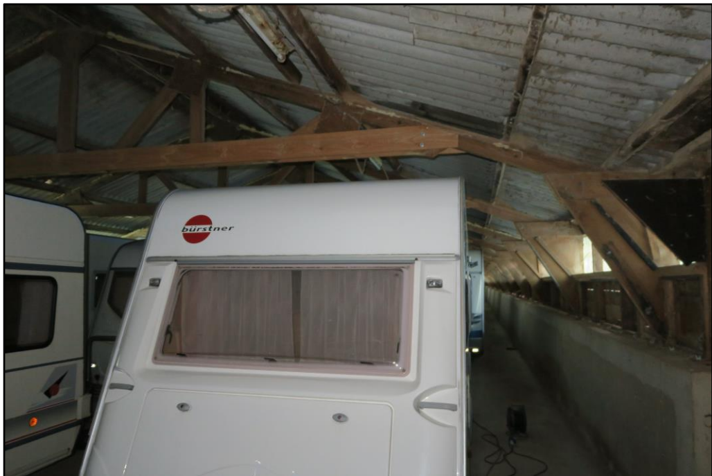
Figuur 4 De loodsen zijn in gebruik als caravan opslag.
