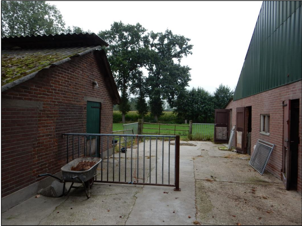
Figuur 3 Visuele indruk van schuur A (rechts) en schuur B (links).
