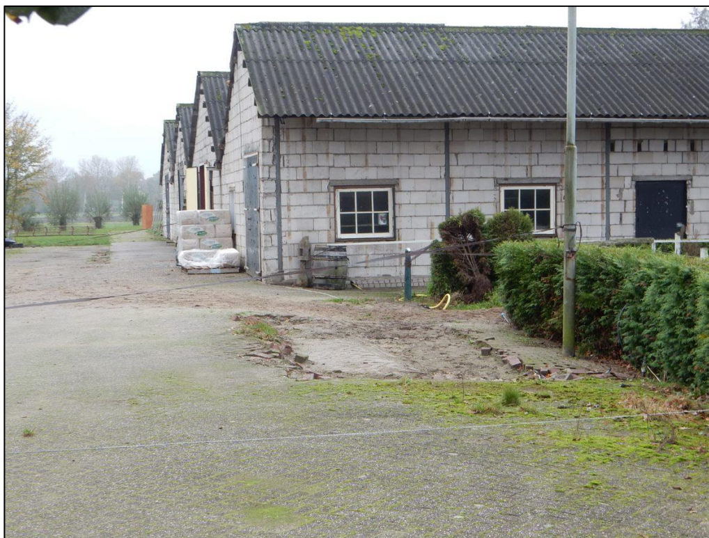
Figuur 1 De paardenstal welke gelegen is op de planlocatie aan de Westenengerdijk 55 te Otterlo.
