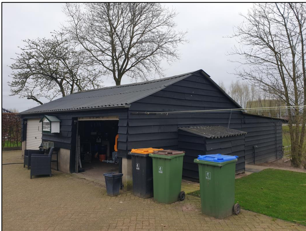
Figuur 2 De te saneren schuur met kippenren.
