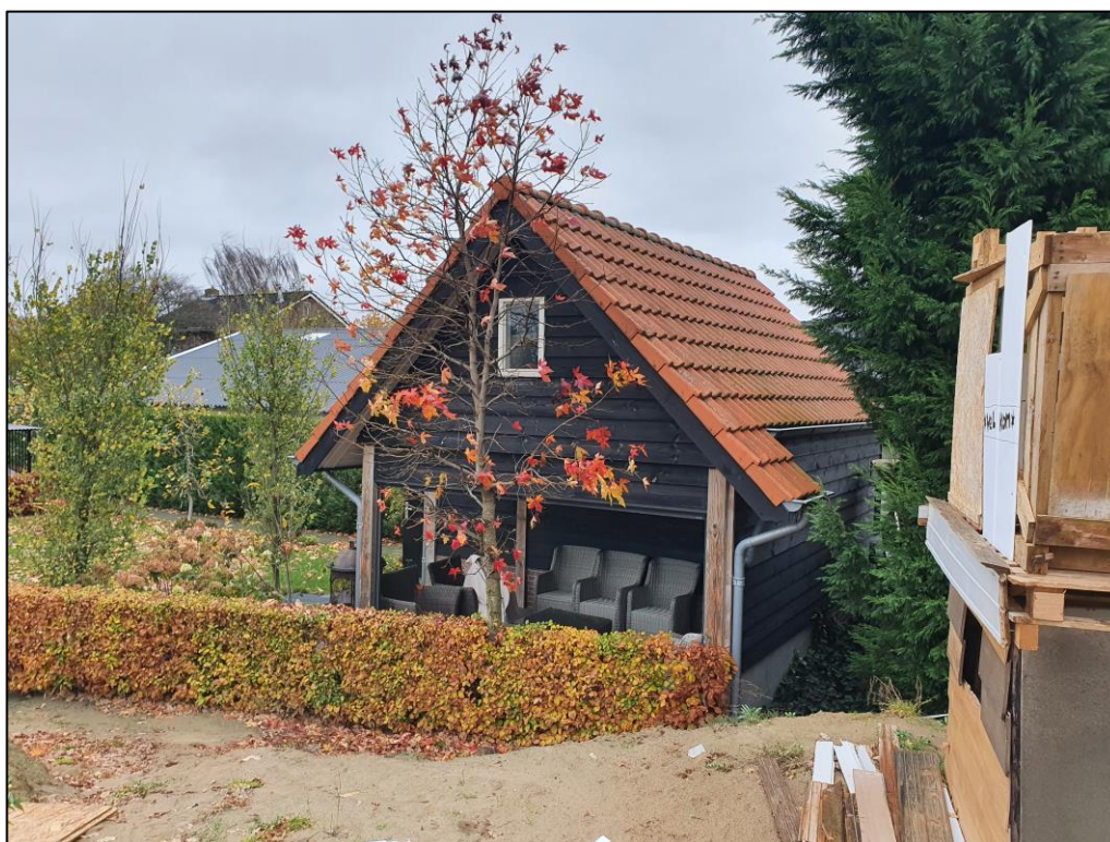
Figuur 2 De te saneren houten schuur met zadeldak.
