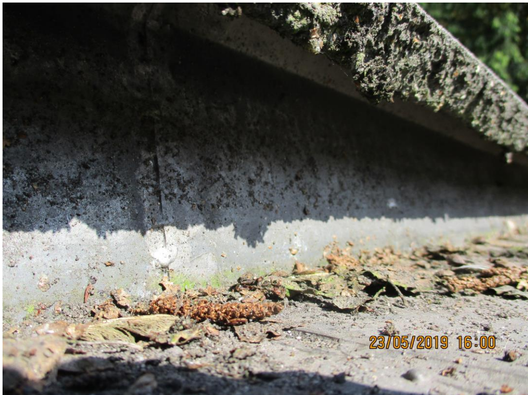
Figuur 5 De dakpannen zijn aan de onderzijde niet toegankelijk voor huismussen.
