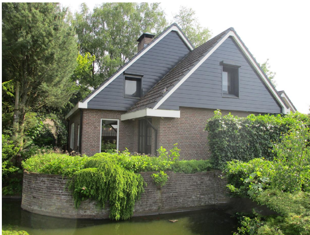
Figuur 1 De planlocatie is gelegen aan de Dorpsstraat 225 te Harskamp en bestaat uit meerdere gebouwen. Hier de woning met een zadeldak uit dakpannen.
