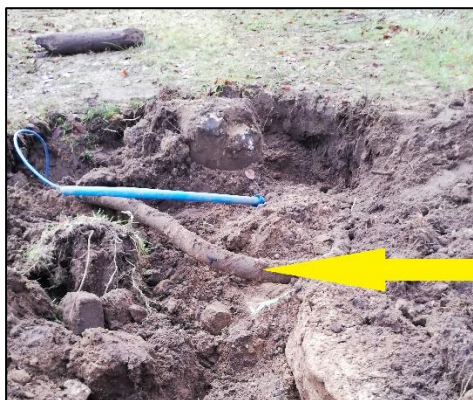
Afb.6 – Aangetroffen kabel in opsporingsgebied
