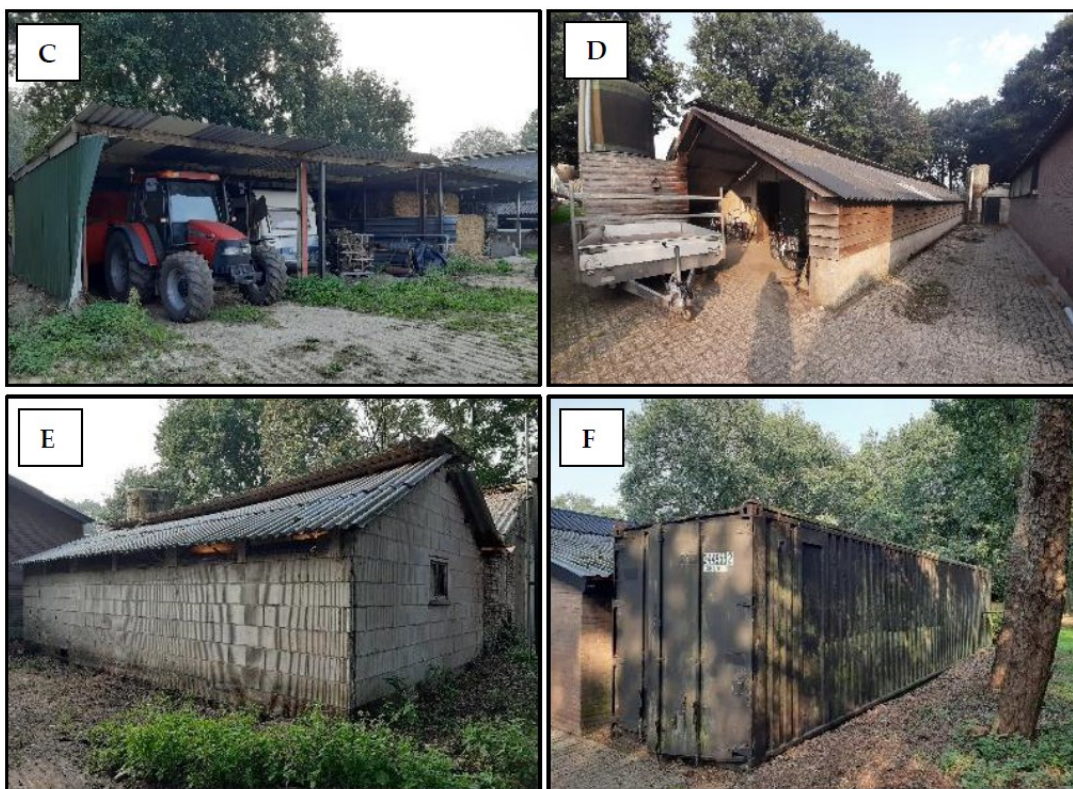
Afbeelding 3.1: Foto's van te slopen/te verwijderen bebouwing
