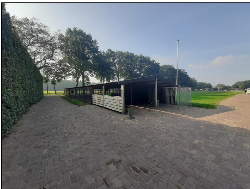
Figuur 4 De oprit en grasweide ten zuiden van de planlocatie.
