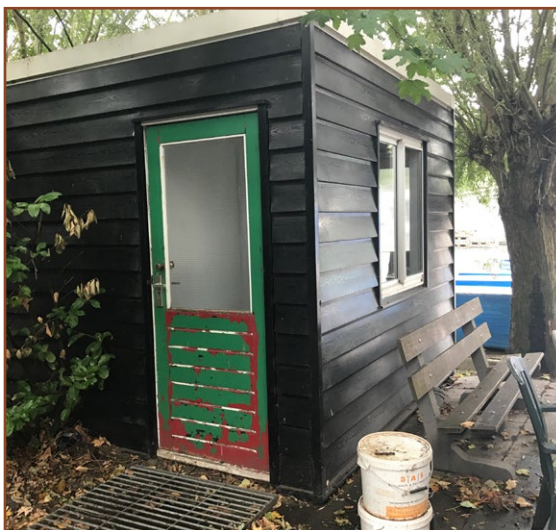
Afb. 2.4: Kantoorunit met kunststof schroten en bitumen dakbedekking.
