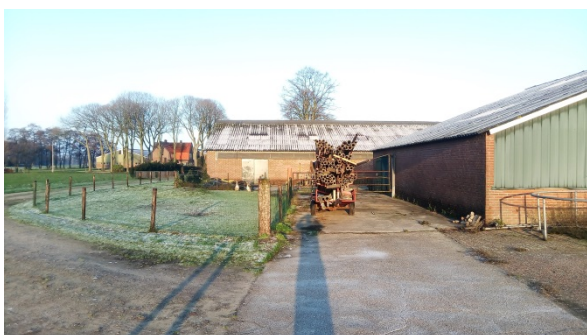
Foto 3: aanwezig puinpad (REPAC) ten westen van de onderzoekslocatie. Aan de rechterkant is loods 2 gelegen.
