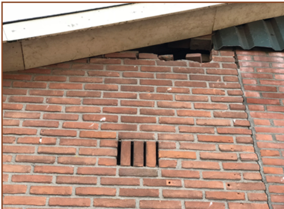
Afb. 2.2: De openingen van de kapschuur 2. Door deze openingen kunnen vleermuizen de spouwmuur bereiken en is hierdoor geschikt als vaste rust- en verblijfplaats.
