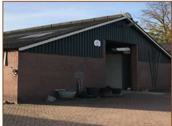
Afb. 2.3: De spouwmuren van opslagruimte 3 is in potentie geschikt als vaste rust- en verblijfplaats.
