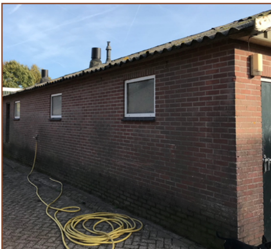
Afb. 2.4: Bollenopslag schuur 5 is niet geschikt als verblijfplaats van Huismussen of vleermuizen. De overgang tussen golfplaten en stenen muur is dichtgemaakt door middel van cement of vogelvides.
