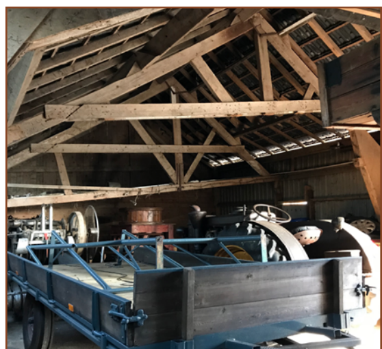
Afb. 2.5: De binnenzijde van kapschuur 10 is open en er ontbreekt isolering of betimmering. Hierdoor is het ongeschikt voor vleermuizen. De bebouwing is vrij toegankelijk voor Huismussen, echter ontbreken nesten van Huismussen.
