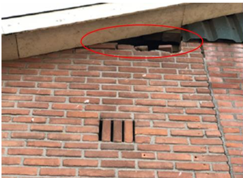
Figuur 2.2 Ontbrekende stenen boven de voor laatvlieger geschikte opening van de te slopen schuur 2 (foto: Ruimte voor Advies).
