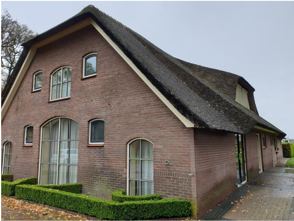
Figuur 1 De planlocatie is gelegen aan de Lage Valkseweg 149 te Lunteren en bestaat uit agrarisch perceel met bedrijfswoning (hier op de foto) en enkele opstallen.
