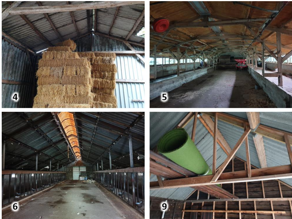
Figuur 5 Fotografische impressie van de binnenzijde van de te saneren opstallen met 4. loods, 5. pluimveestal, 6. rundveestal en 9. berging.
