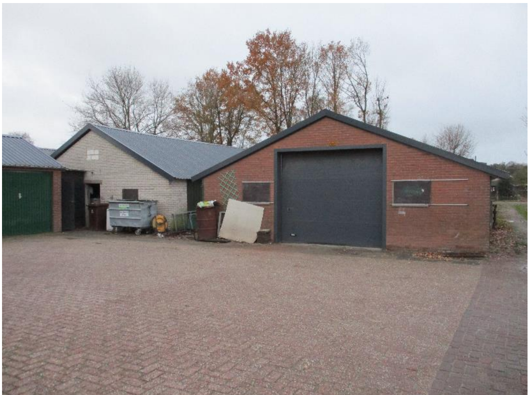
Figuur 2 De schuur en drietal loodsen zullen gesaneerd worden in de beoogde ontwikkeling.
