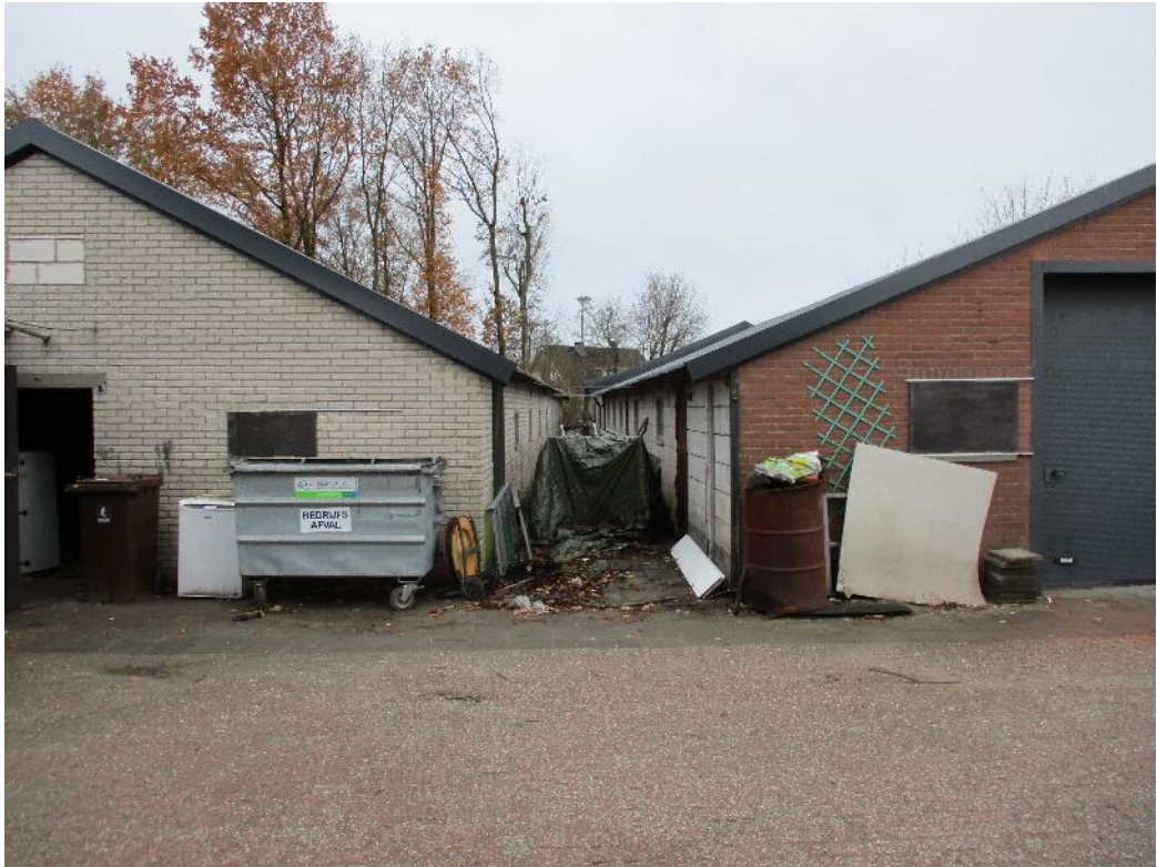
Figuur 3 De loodsen zijn opgetrokken uit gemetselde steense/beton muren en damwanddaken. Op de foto zijn 2 van de 3 loodsen zichtbaar.
