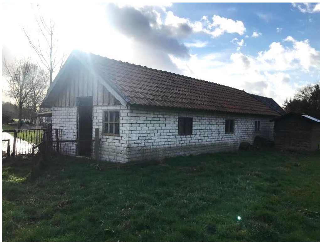
Figuur 2 Het plangebied betreft een woonperceel en een perceel met verschillende schuren erop gesitueerd. Op de foto is schuur II afgebeeld.
