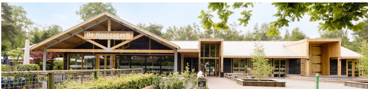
Bestaand centrumgebouw en horecavoorziening
