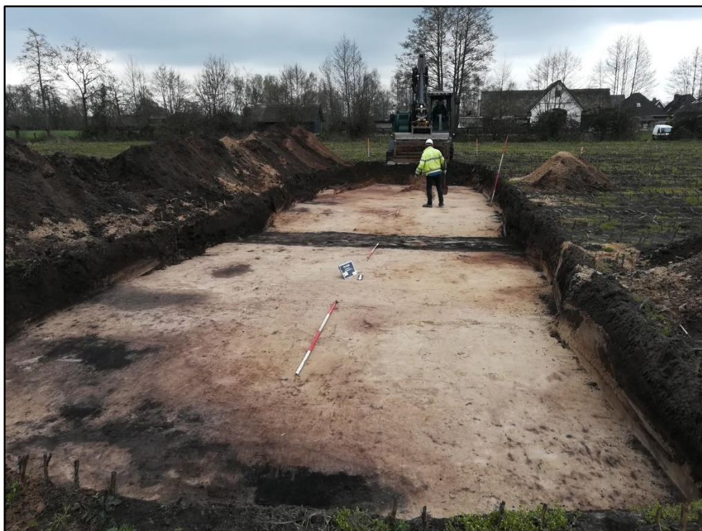
Figuur 3 Sfeerfoto van de werkzaamheden.
