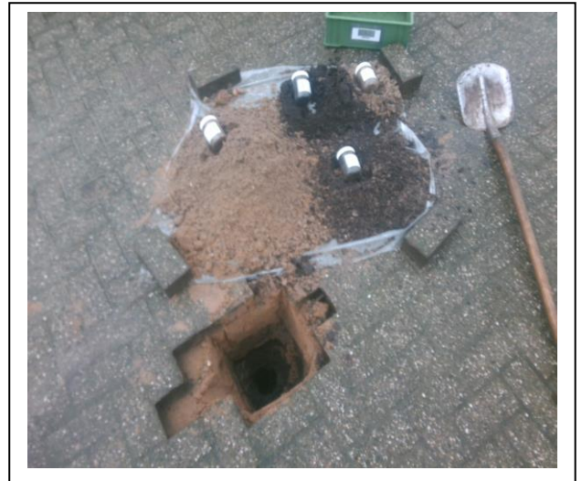
Foto: Inspectiegat A02
