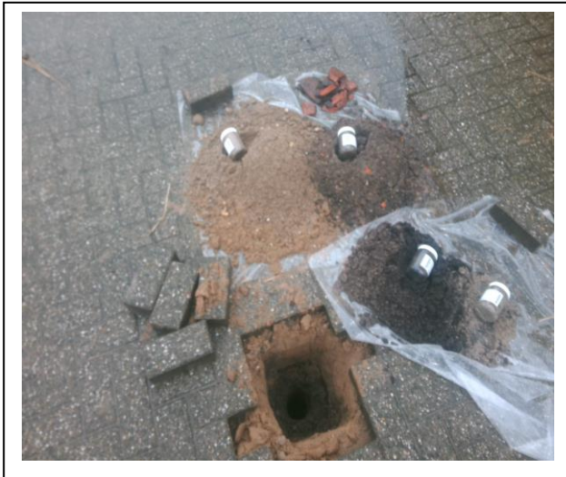
Foto: Inspectiegat A03
